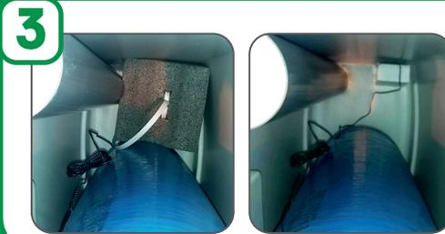
УДАЛИТЬ ИЗ КОРПУСА МАКСИКАБИНЕТА ПОЛУЖЕСТКУЮ РАСПОРКУ, СЕТЕВОЙ АДАПТЕР И КОМПЛЕКТ ШТУЦЕРОВ ДЛЯ ПРИСОЕДИНЕНИЯ УПРАВЛЯЮЩЕГО КЛАПАНА
